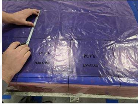
Görsel 6.5. Tamir uygulanacak katların şablonun çizilmesi
