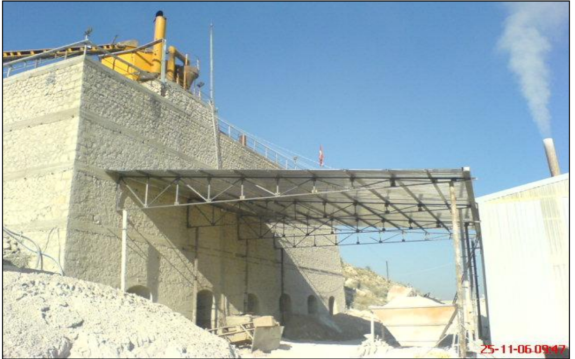
Resim 2.2. Ölçüm yapılan fabrika
