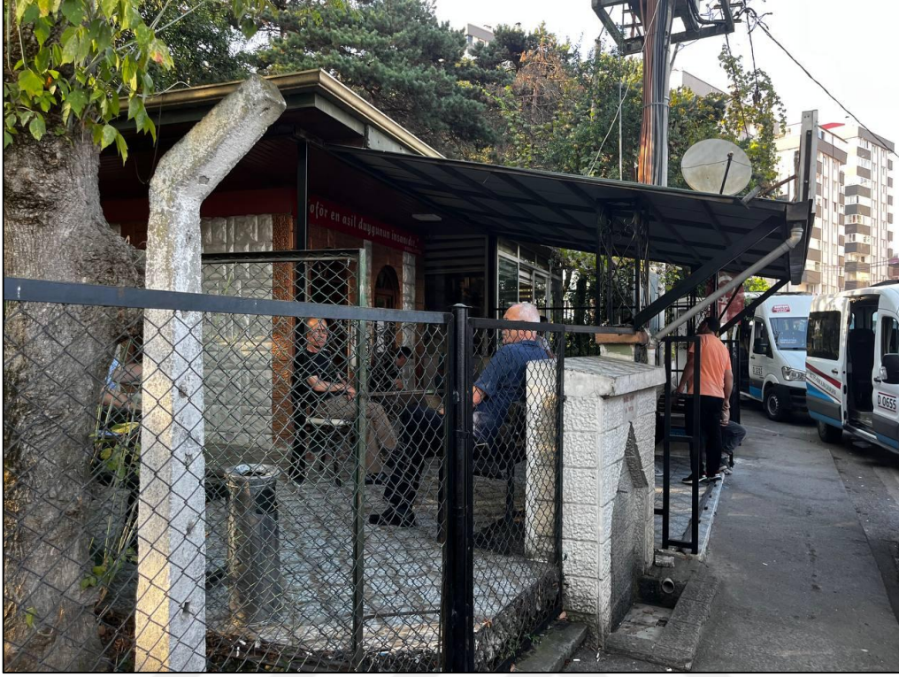
Şekil 34. B noktası mevcut durumu görseli
