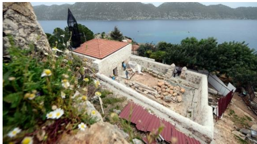
Görsel 3.1 Kaleköy Camisi Restorasyonu/I
