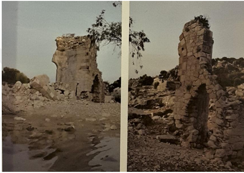
Görsel 3.4 Tersane Koyu Kilise Yapısı
