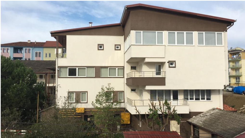
Şekil 4.10: Huzurevinin doğu cephesi (2022)
