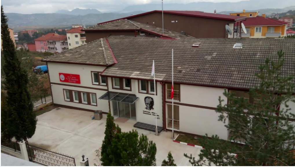
Şekil 4.9: Huzurevinin batı cephesi (2022)
