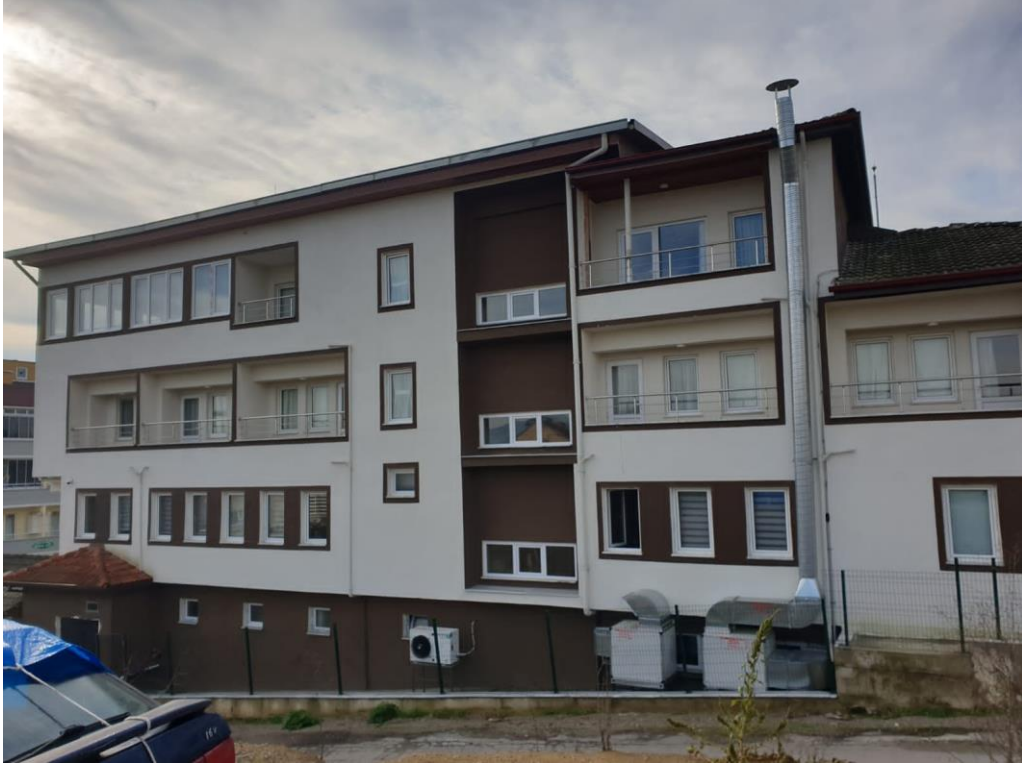
Şekil 4.11: Huzurevinin kuzey cephesi (2022)
