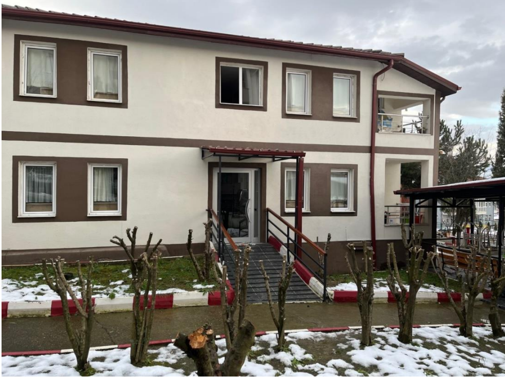
Şekil 4.14: Bina giriş rampası (2022)
