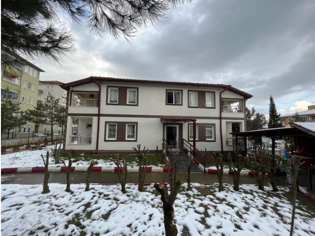
Şekil 4.12: Huzurevinin güney cephesi (2022)
