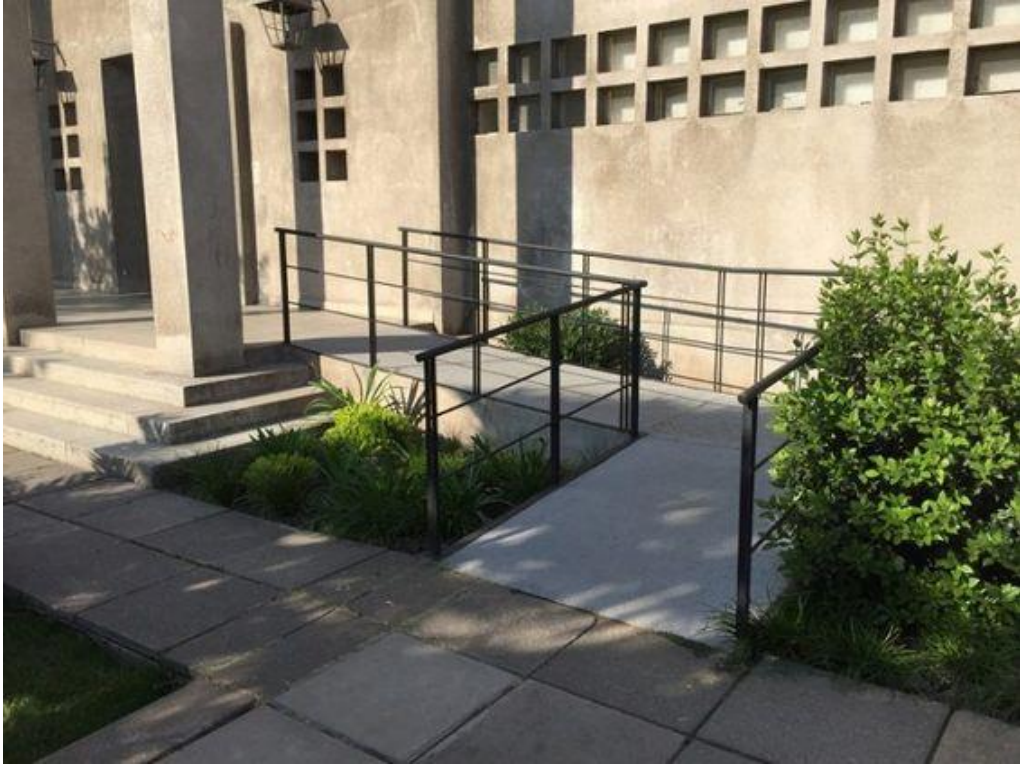
Şekil 5.2: Bina giriş rampası örneği-2 (Anonim, 2022)
