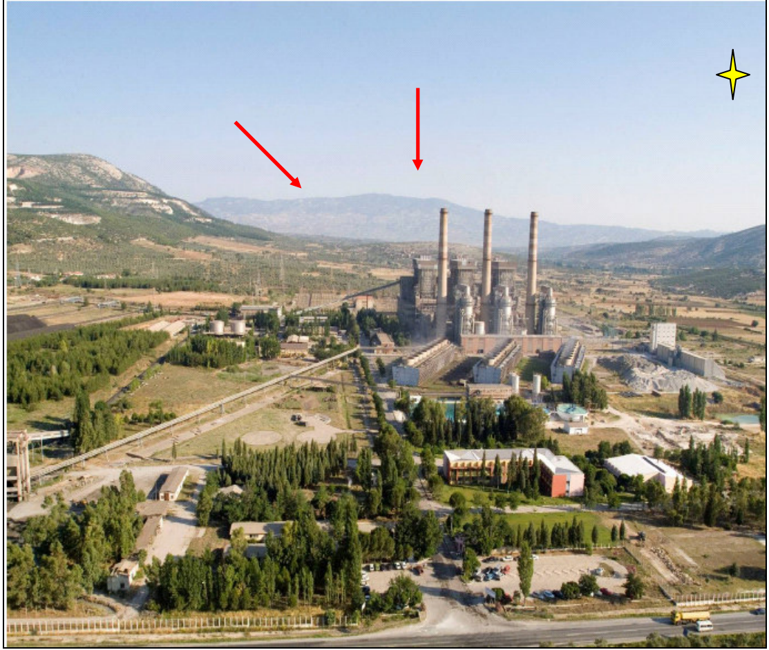
Foto 40: Yatağan Termik Santralinin Görünüşü
