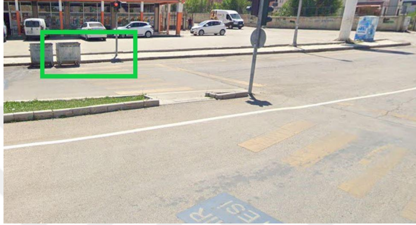
Şekil 4.16. Yaya yolu ile kaldırım kesişiminde engelli rampası uygulamasının olmayışı
