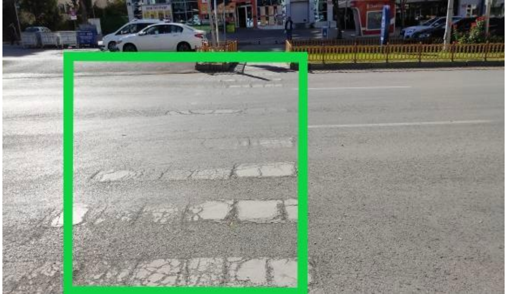
Şekil 4.12. Yaya geçidinin yol yüzeyinden silinmesi ve sürücüler tarafından bu yaya geçidinin fark edilmesinin zorlaşması.
