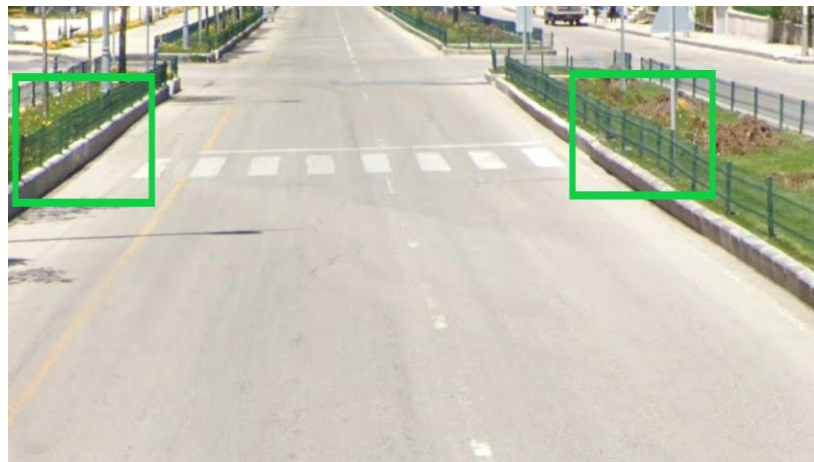
Şekil 4.17. Yol yüzeyine yaya yolu işlenmesine rağmen refüjlerde yaya geçiş alanı bulunmaması.
