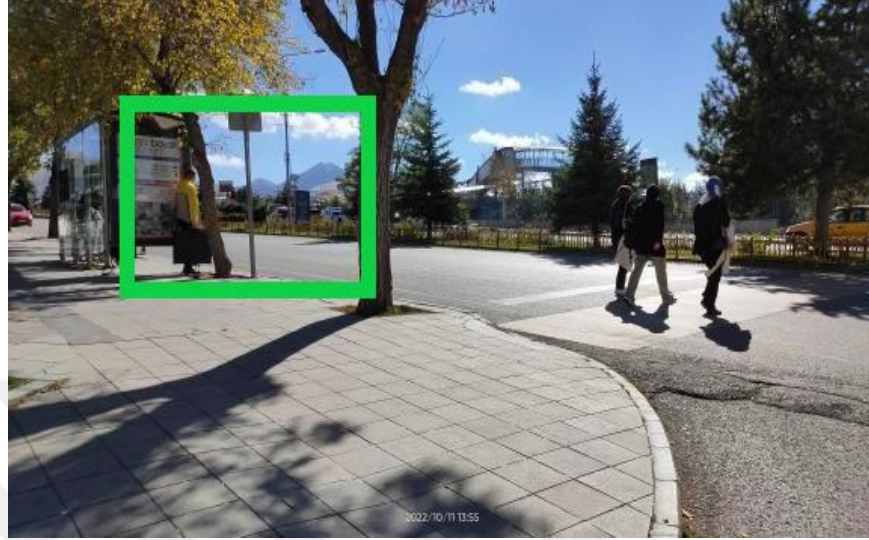
Şekil 4.14. Yaya geçidinin hemen öncesine otobüs durağı yerleştirilmesi
