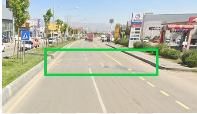
Şekil 4.18. Trafik akışının yüksek hızlarda seyrettiği bir yolda yaya üst veya alt geçidinin bulunmaması ve yol yüzeyine işlenmiş olan yaya geçidinin neredeyse tamamen silinmiş olması.
