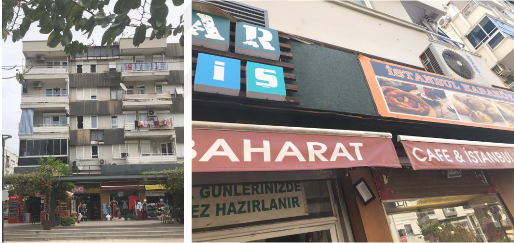
Şekil 4.7. Abdi İpekçi ve Şarampol Caddelerinde bulunan bina cepheleri (Kişisel arşiv, 2024)
