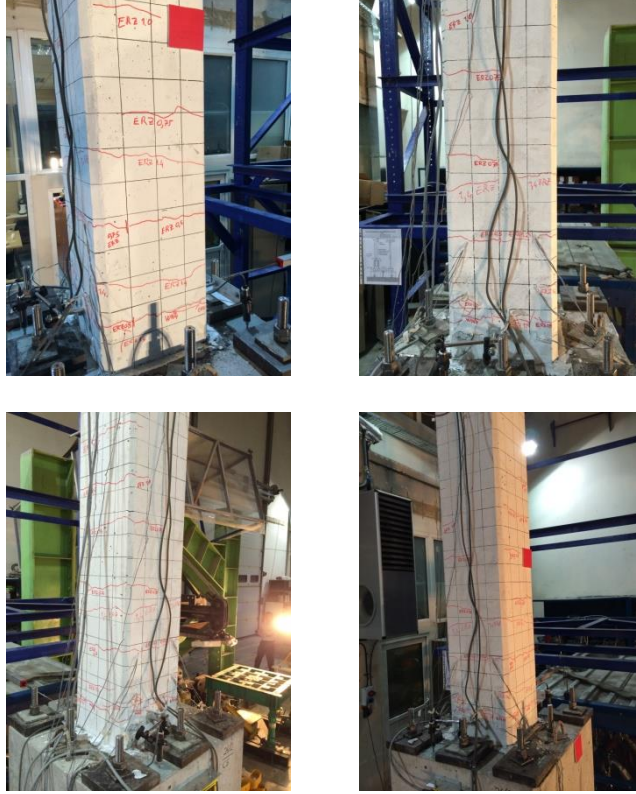
Şekil 3.60 : ERZ1.00 testi sonrasında kolonda bulunan eğilme çatlakları.
