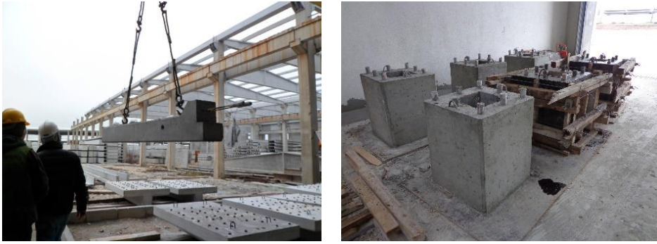
Şekil 3.38 : Yapı elemanlarının depolanması.
