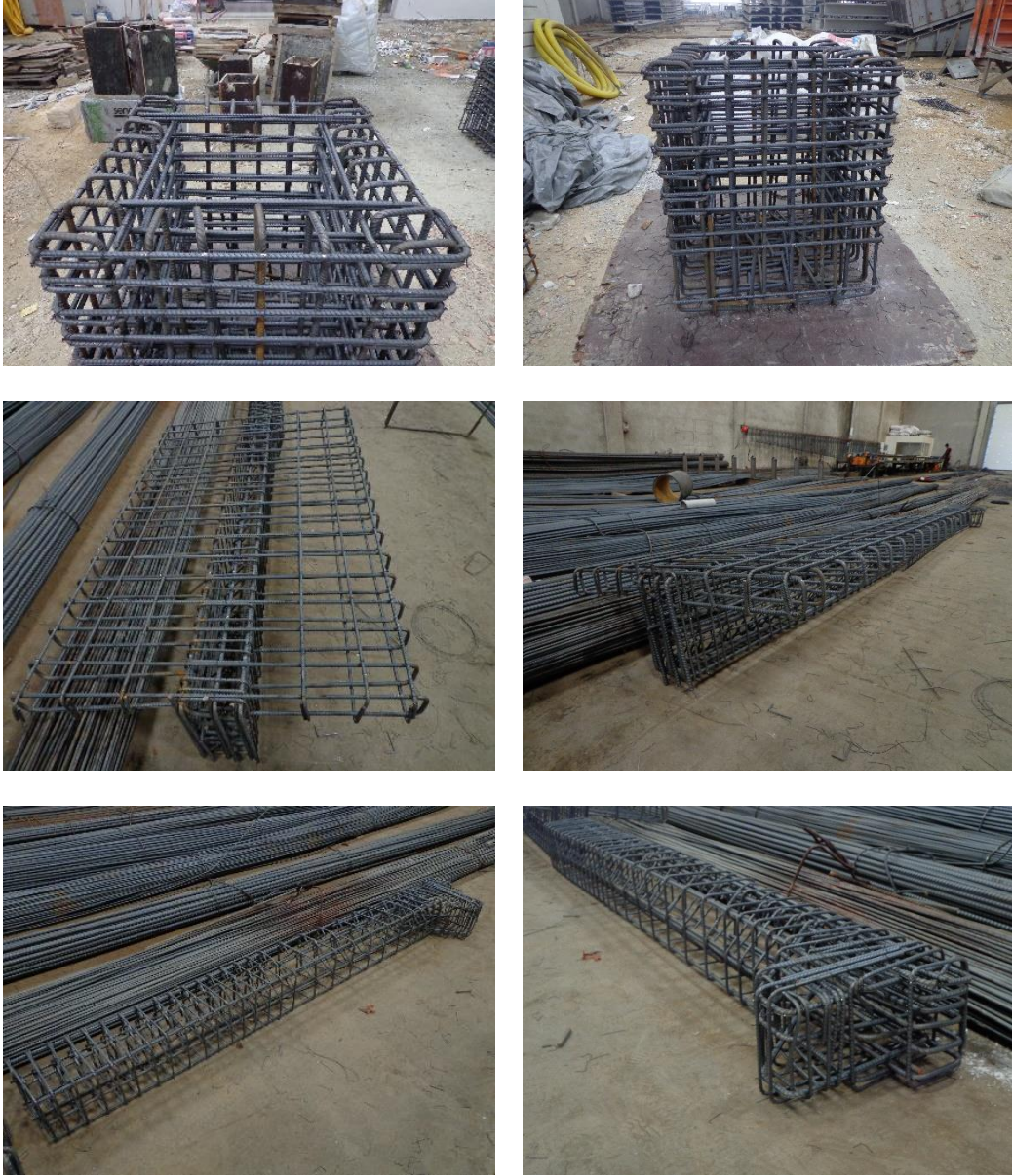
Şekil 3.33 : Yapı elemanlarının donatıları.
