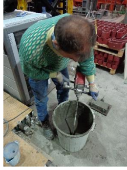
Şekil 3.40 : Soket temel-kolon montajı (Harcın hazırlanması ve yerleştirilmesi).
