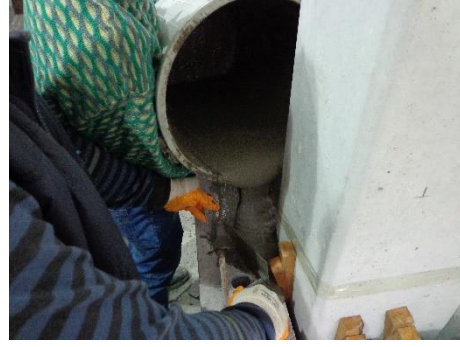
Şekil 3.40 : Soket temel-kolon montajı (Harcın hazırlanması ve yerleştirilmesi).
