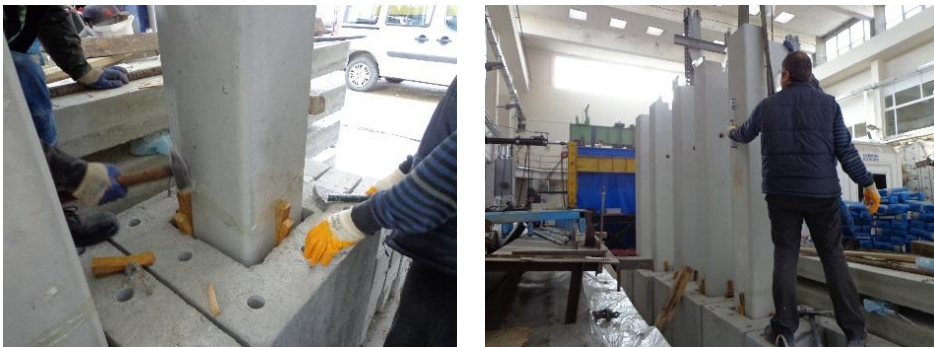
Şekil 3.39 : Soket temel-kolon montajı (Kolonların düşeyliğinin sağlanması).
