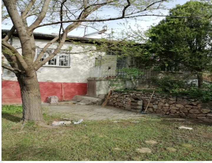
Fotoğraf 3. İlçe Merkezinde Tek Katlı Bahçeli Kerpiç Bir Ev Kaynak: Ayşegül Aslan(2018)
