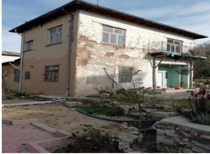
Fotoğraf 4. İlçe Merkezinde Kerpiç, İki Katlı ve Bahçeli Ev Kaynak: Ayşegül Aslan(2018)
