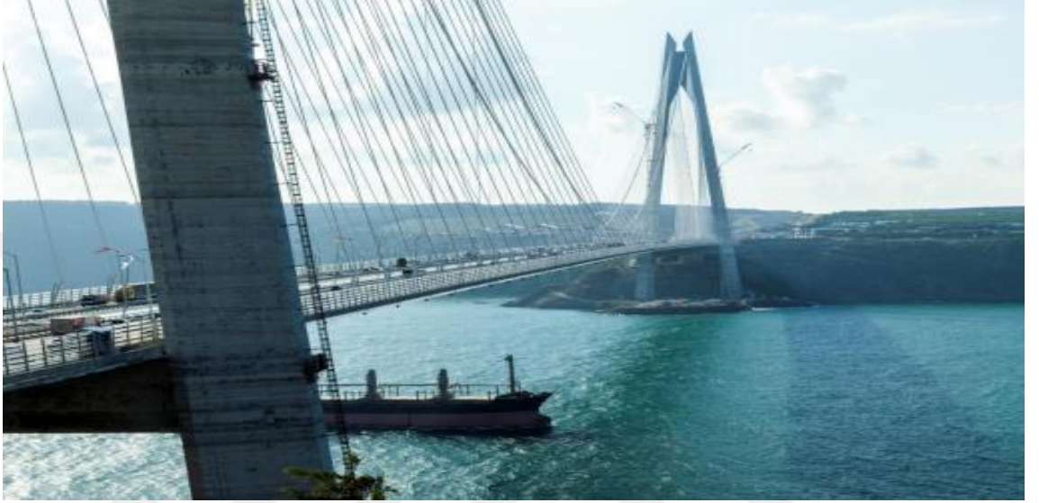
Şekil 18. Yavuz Sultan Selim Köprüsü
