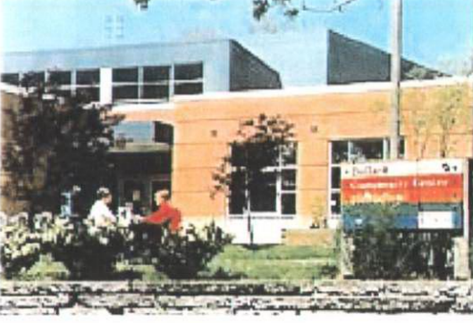
Fotoğraf 5. Ballard "Community Center" Görünüşü
