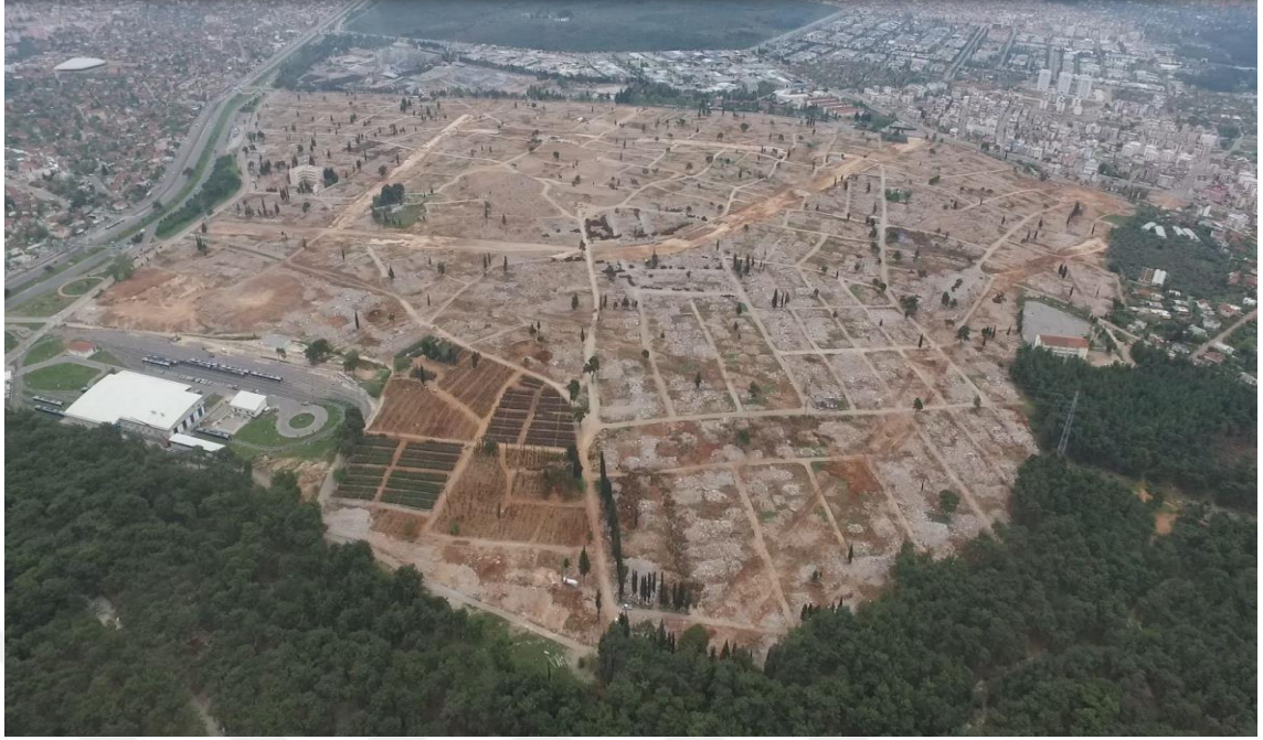
Şekil 4. 51. Kepez – Santral mahallesi (14.05.2017)
