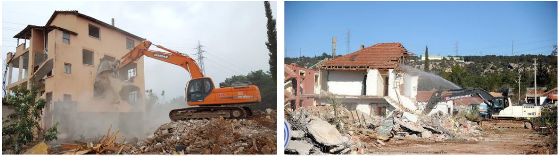
Şekil 4. 47. Kepez – Santral mahallesi (12.09.2016)
