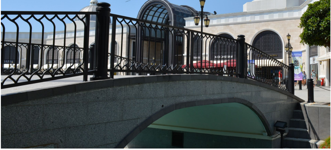
Şekil 21:Yapay kanalı geçmek için kullanılan köprü
