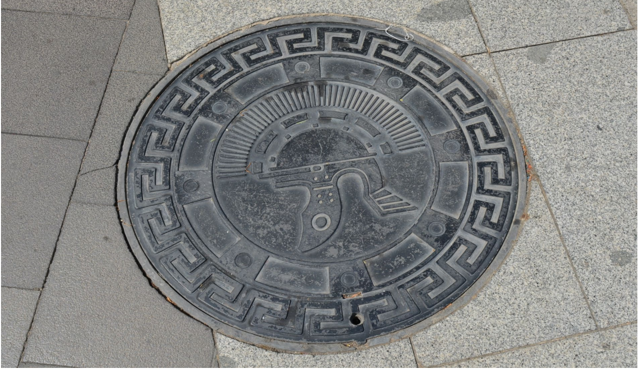
Şekil 23: Komplekste kullanılan kanalizasyon kapakları
