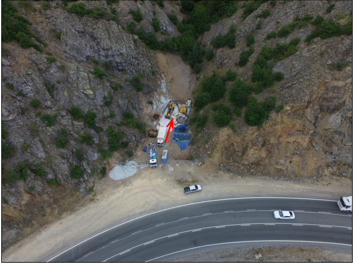
Şekil 4. 2 nolu hizmet kuyusu girişinin havadan fotoğrafı
