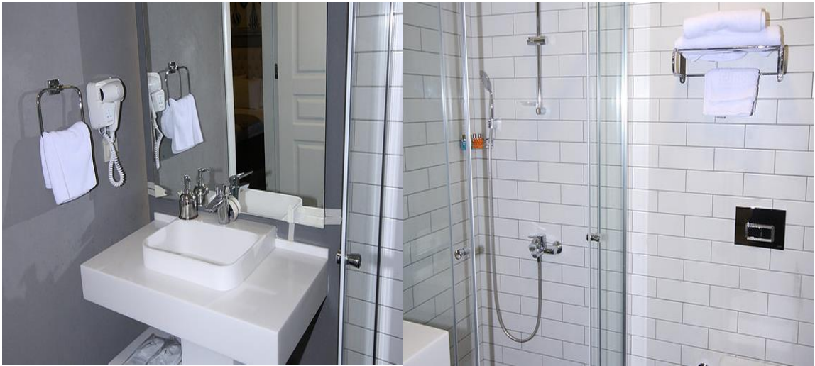
Şekil 5.18 Restorasyon Sonrası Banyo Görünümleri
