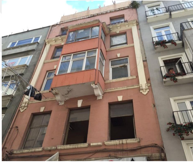
Şekil 5.7 Yapının restorasyon öncesi cephe görünümü
