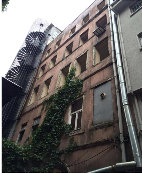
Şekil 5.3 Restorasyon Öncesi Arka Cephe Görünümü
