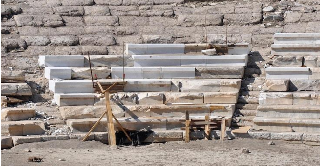
Şekil 3.2 Aspendos Antik Tiyatrosu Restorasyon Çalışması (url 6)
