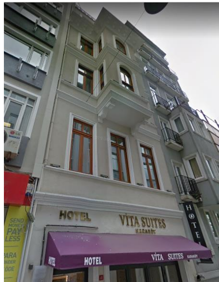
Şekil 5.16 Restorasyon Sonrası Cephe Görünümü
