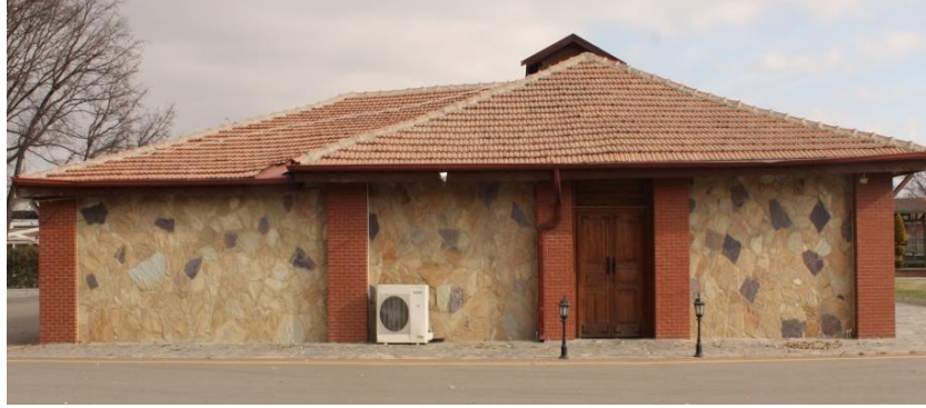
Görsel 4.3. Batı cephe görünüşü (Mimor Mimarlık arřivi)
