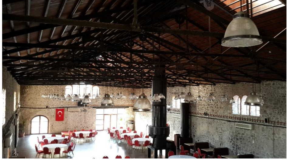
Şekil 4.11 Kafeterya iç mekânındaki aydınlık durumu
