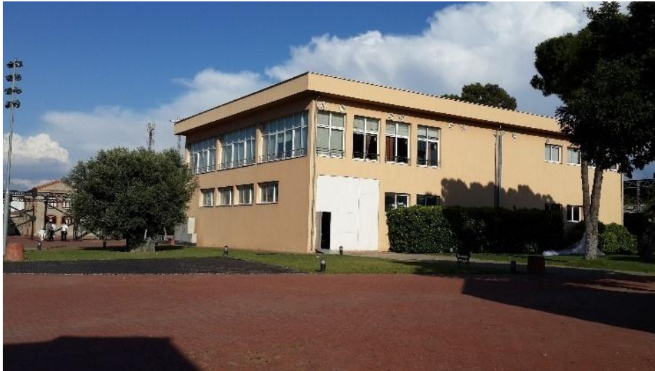
Şekil 3. 16 Restoran dış görünüm
