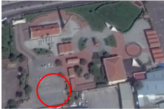
Şekil 3.20 Gazometre (15000m 3 yakıt depolama tankı), kırmızı daire ile belirtilmiştir.
