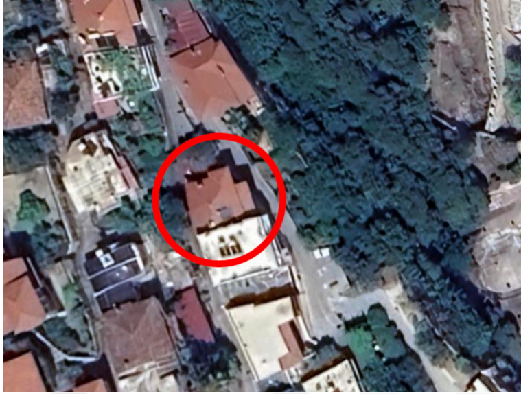
Şekil 4.22. 401 Ada 1 Parselde bulunan geleneksel konutun konumu
