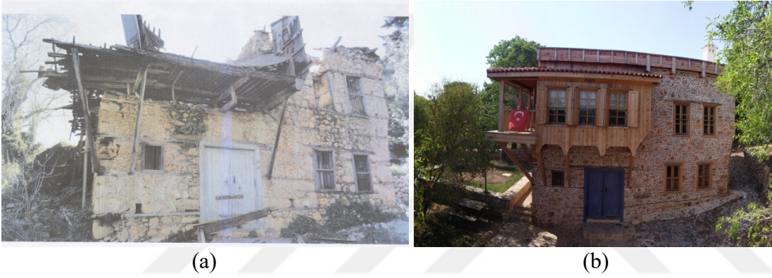
Şekil 4.74. Kayhanlar Konutu ön cephenden fotoğrafı (a) Restorasyon öncesi; (b) Restorasyon sonrası
