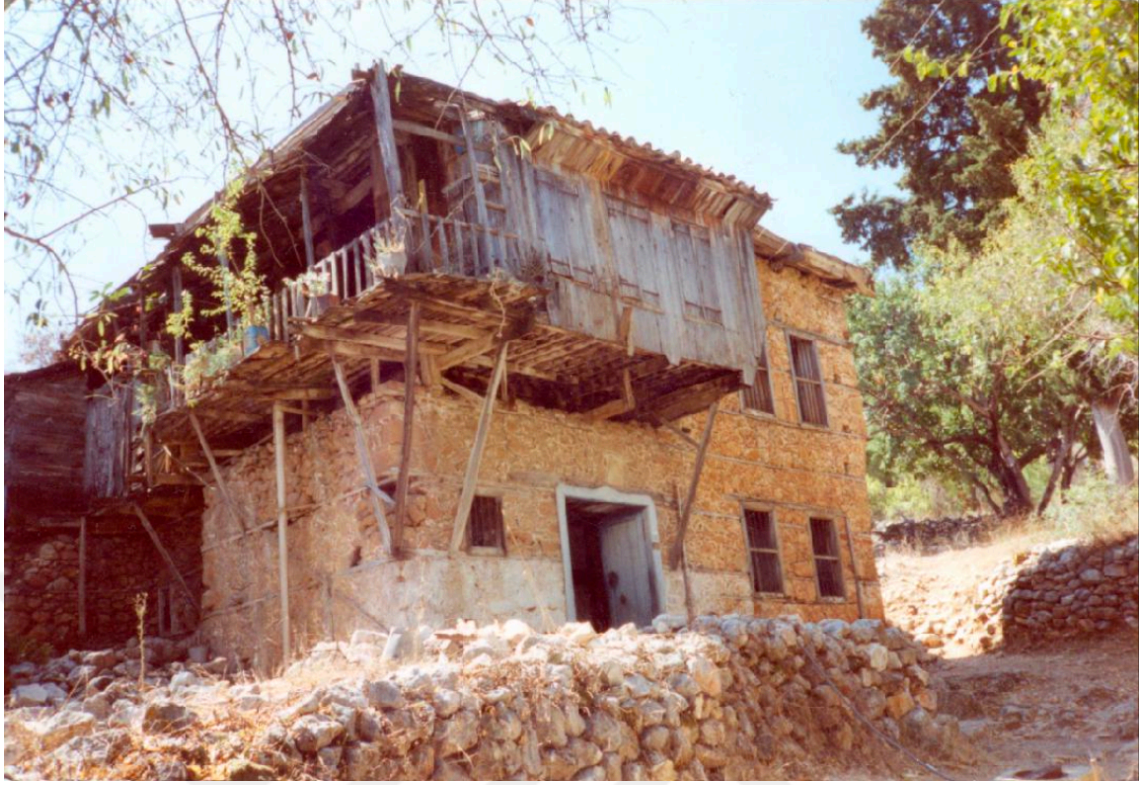
Şekil 4.69. 263 Ada 70 Parselde bulunan geleneksel konutun 1988 yılından fotoğrafı
