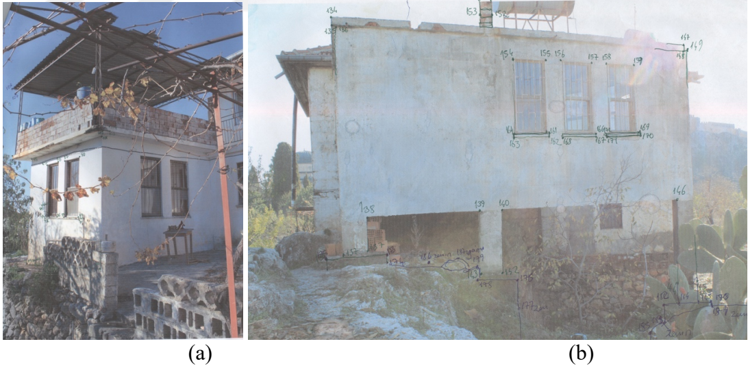
Şekil 4.56. Sipahioğlu Konutu restorasyon öncesi dış cephe fotoğrafları; (a) Güneybatı cephesi (b) Kuzey cephesi
