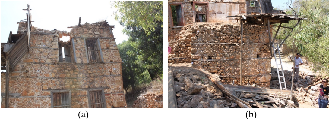
Şekil 4.75. Kayhanlar Konutu restorasyon öncesi fotoğrafları (a) Kuzey cephe; (b) Doğu cephe
