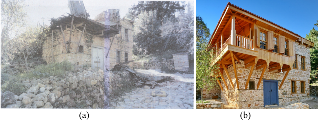
Şekil 4.73. Kayhanlar Konutu Kuzeydoğu cephesinden fotoğrafı (a) Restorasyon öncesi; (b) Restorasyon sonrası
