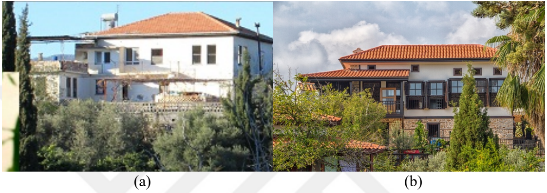
Şekil 4.55. Sipahioğlu Konutu ön cephe fotoğrafı (a) Restorasyon öncesi; (b) Restorasyon sonrası
