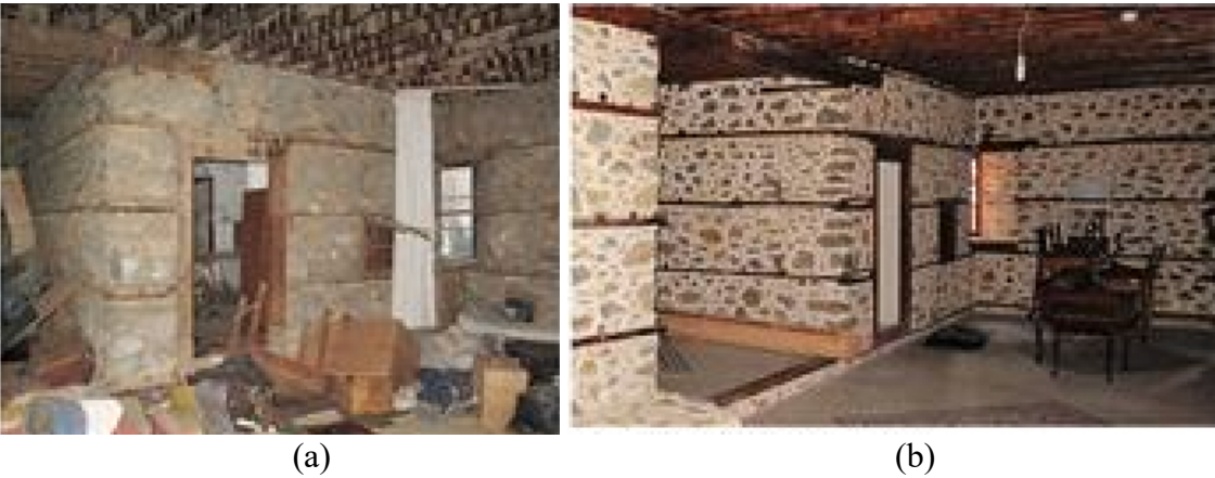
Şekil 4.11. Hasanağalar Konağı zemin kat ahır/çok amaçlı salon mekanından fotoğraf; (a) Restorasyon öncesi (b) Restorasyon sonrası
