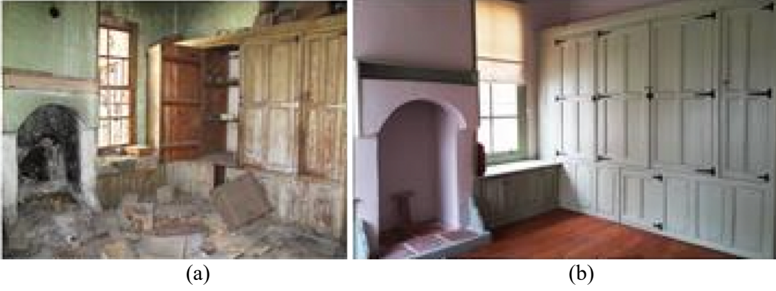
Şekil 4.9. Hasanağalar Konağı birinci kat mutfak mekanından fotoğraf; (a) Restorasyon öncesi (b) Restorasyon sonrası
