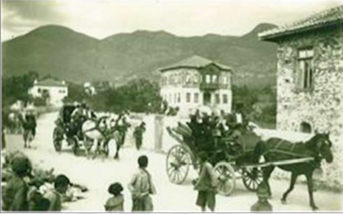
Şekil 4.2. 256 Ada 56 Parselde bulunan geleneksel konutun 1900'lü yılların başından bir fotoğrafı
