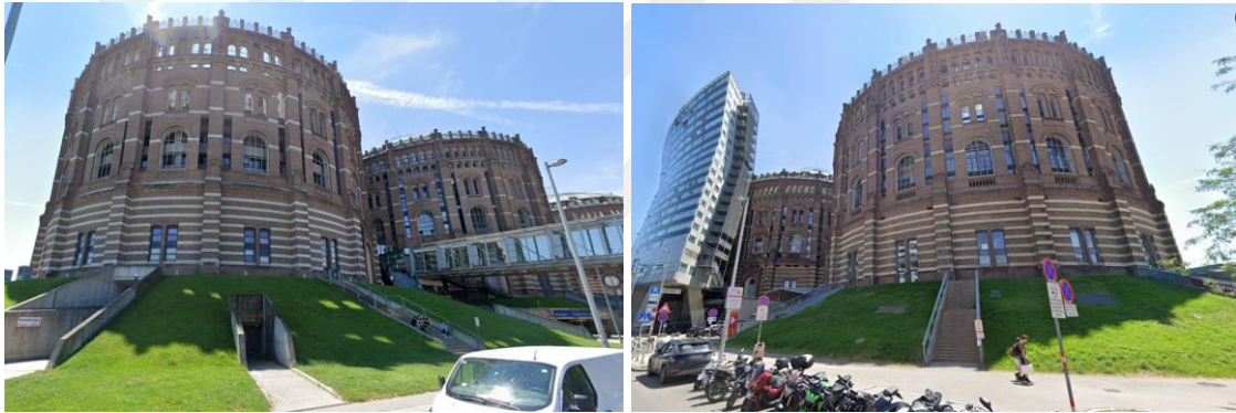
Şekil 2.8. Viyana Gazometreleri (Google Street View üzerinden çekilmiştir.)
