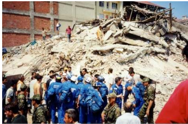
Şekil 5.6. İmar affından faydalanan Ersoy apartmanı.
