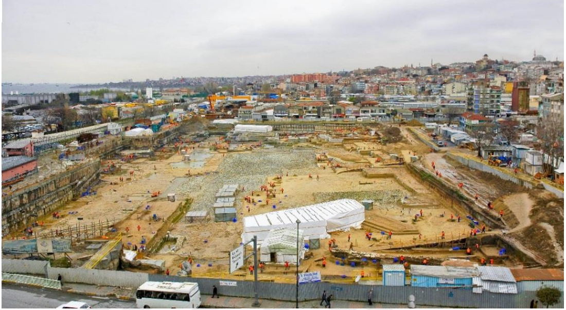
Şekil 1.1: Yenikapı kazı alanının doğudan görünüşü.
