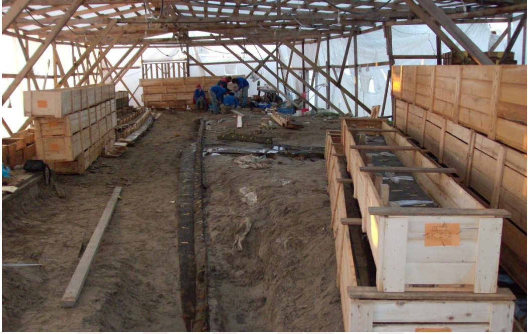
Şekil 1.14: Koruyucu çadır içerisinde gerçekleştirilen demonte işlemleri.
