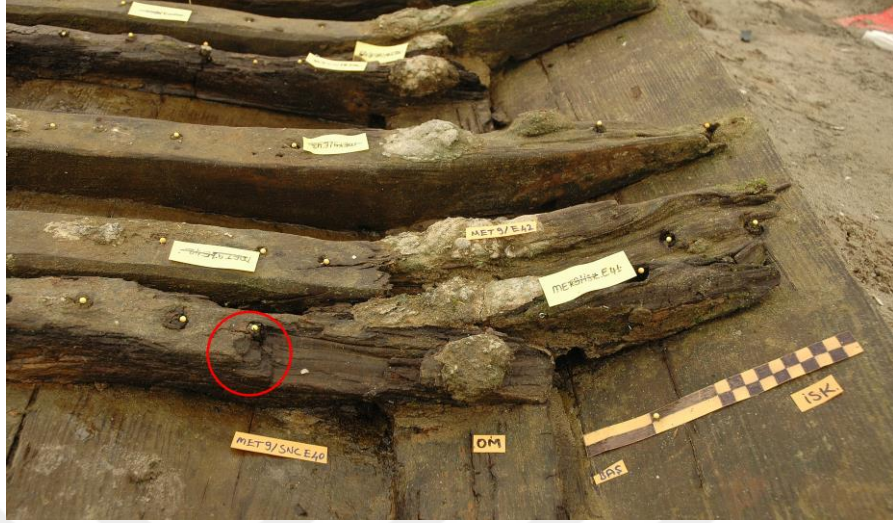
Şekil 2.10: İ-E41 numaralı ahşap eleman üzerinde örnek alımının yapıldığı bölge.
