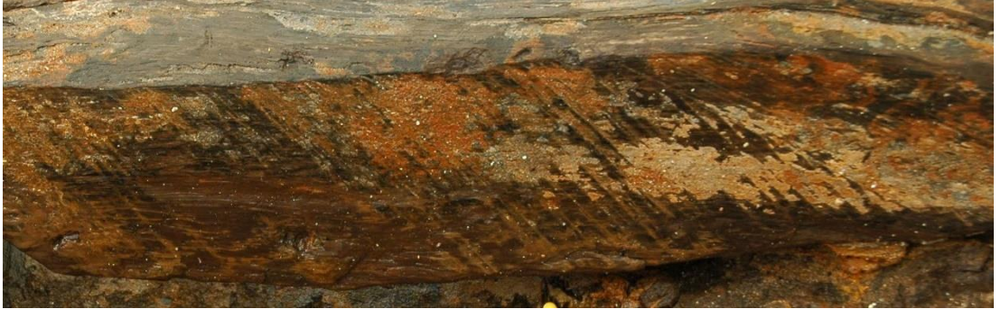
Şekil 70: E11 eğrisi üzerindeki testere izleri
