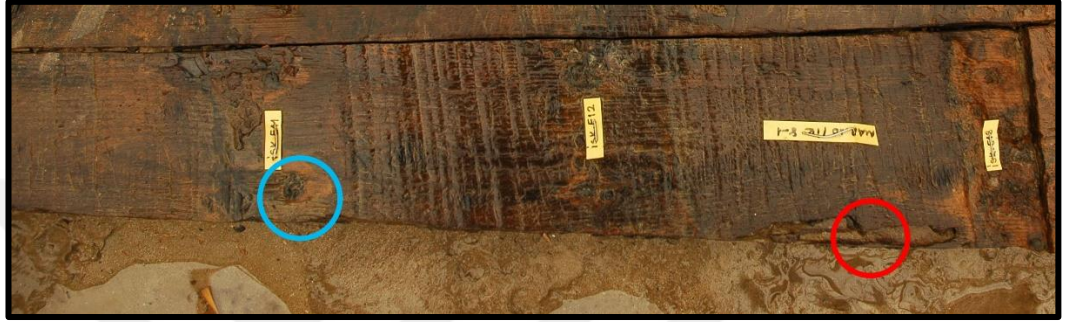
Şekil 2.12: İK8-1 örneklerinin alındığı bölge. Mavi: korozyonlu bölge; kırmızı: korozyona yakın bölge.
