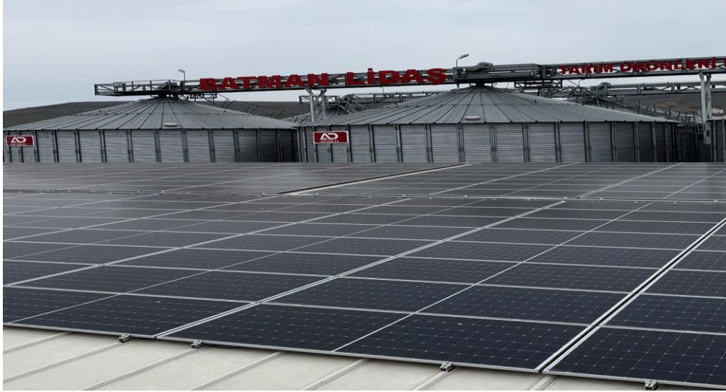
Şekil 5.2. Çatı Tipi GES (Batman Lidaş)
