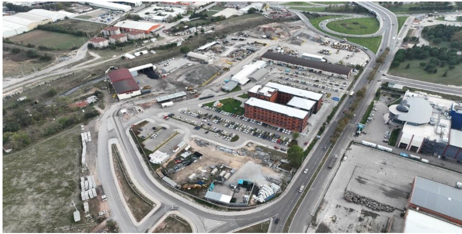
Şekil 3.4. Bursa büyükşehir belediyesi ek hizmet binası drone çekimi
