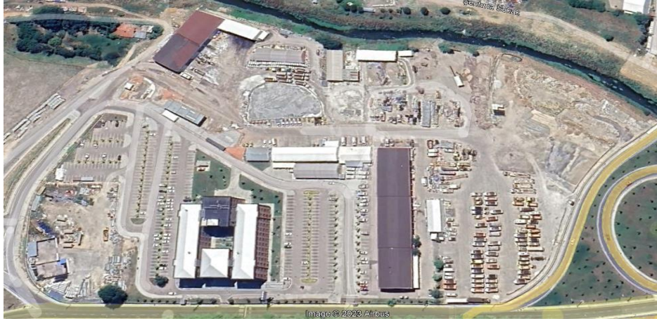
Şekil 3.7. Bursa büyükşehir belediyesi ek hizmet binası drone çekimi
