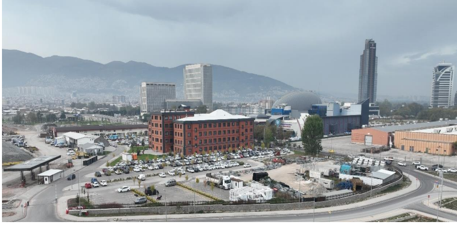
Şekil 3.5. Bursa büyükşehir belediyesi ek hizmet binası drone çekimi
