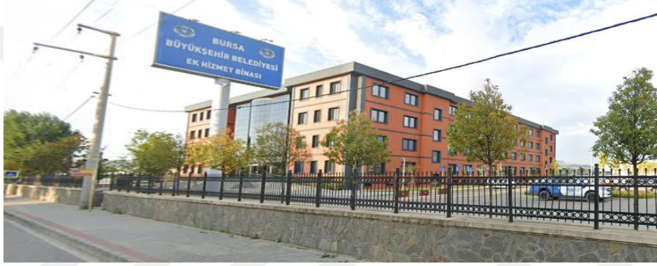
Şekil 3.6. Bursa büyükşehir belediyesi ek hizmet binası drone çekimi
