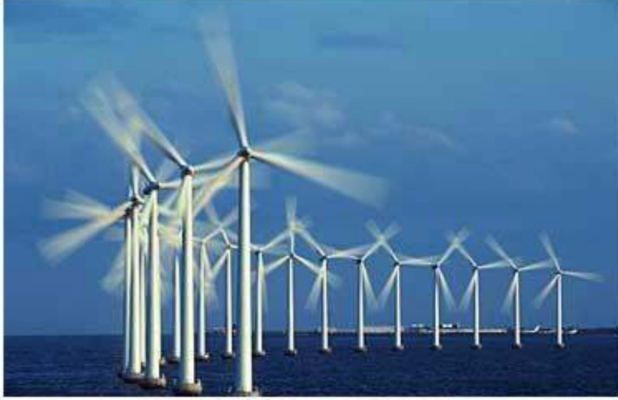
Şekil 5: Rüzgar Enerjisi Santrali
