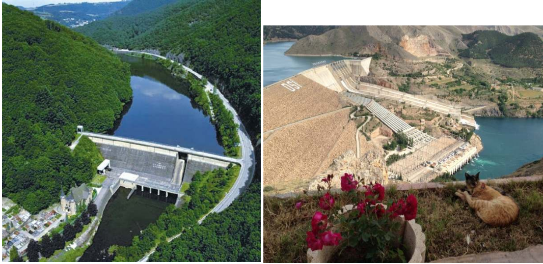
Şekil 6-7: Hidroelektrik Enerji Santrali
