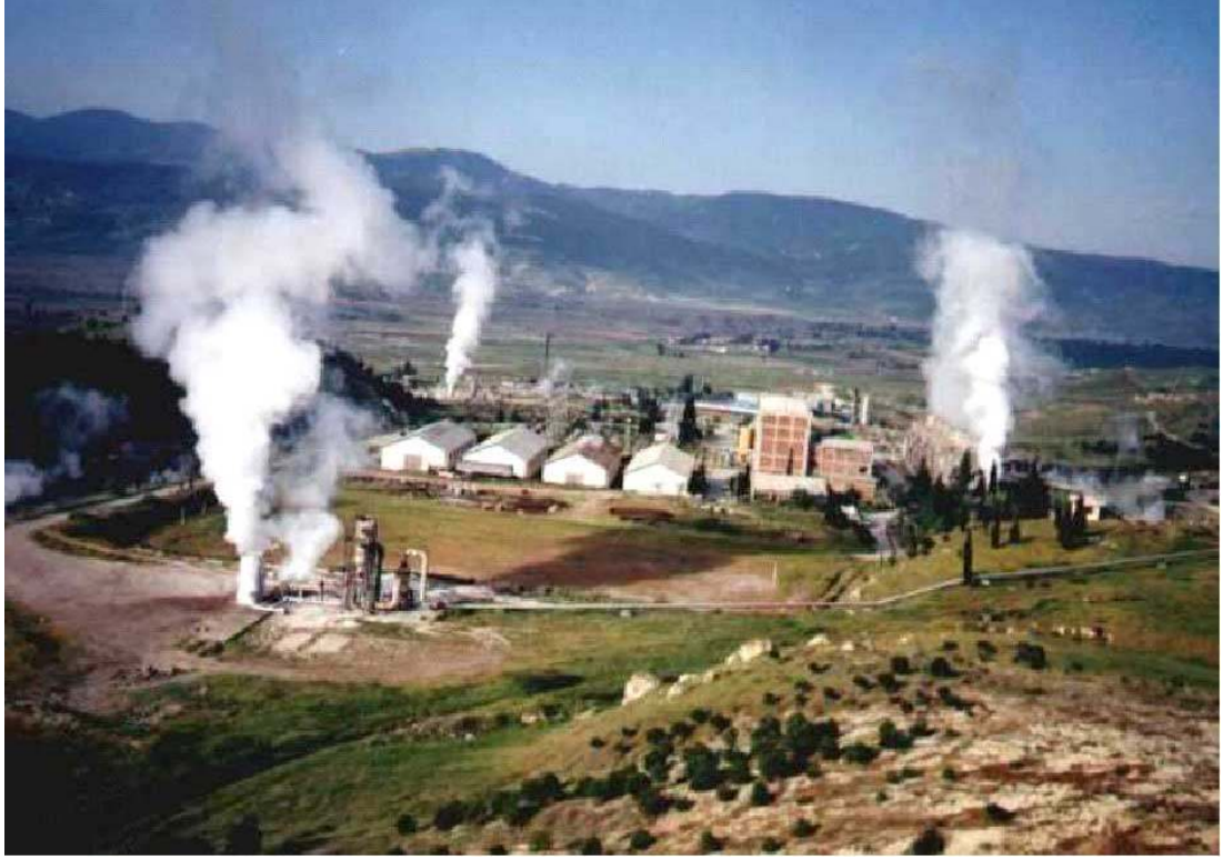
Şekil 8: Jeotermal Enerji Santrali
