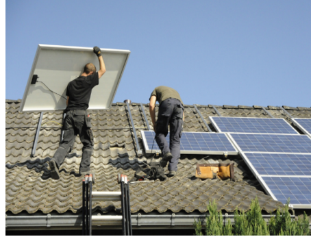
Görsel 2.2. Fotovoltaik Panel Uygulama
