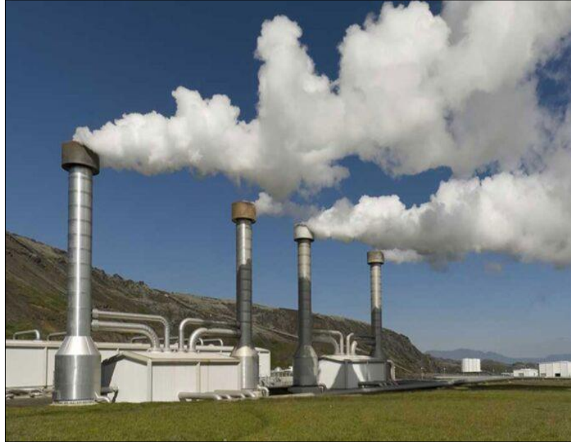
Şekil 6. Jeotermal enerji santrali (URL-3, 2022).
