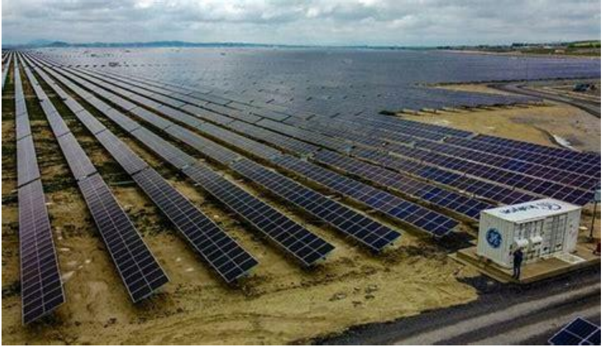
Şekil 3.22: Konya Karapınar güneş enerjisi santrali'nin genel görünümü (Mangırcıoğlu, 2023)
