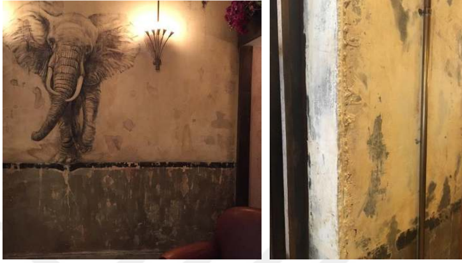
Resim 96.The House Café Grand Pera İç Mekan Duvar Horasan Harcı üzeri Boya Uygulaması (URL 104, Işıkcı Arşivi 2018)
