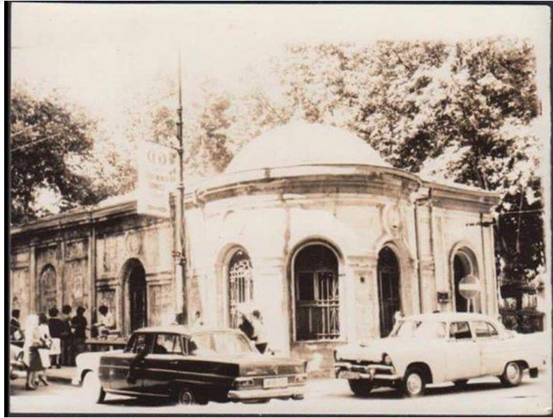
Resim 81. The House Café Corner Restorasyon Öncesi Görünümü (URL 89)
