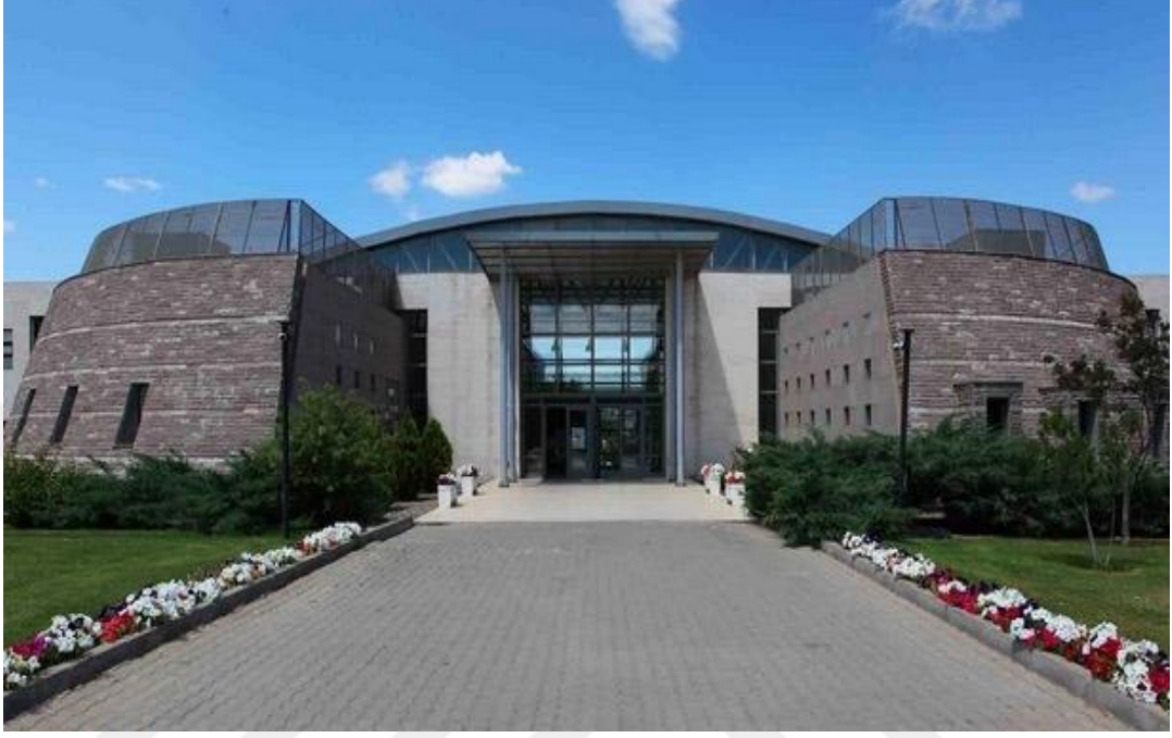
Fotoğraf 1. ODTÜ Teknopark İkizler Binası
