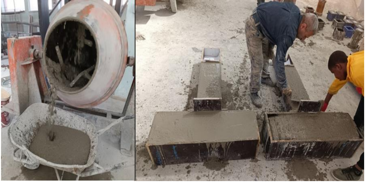
Şekil 3.34. Betoniyer ile karıştırma işlemi ve betonun kirişlere yerleştirilmesi
