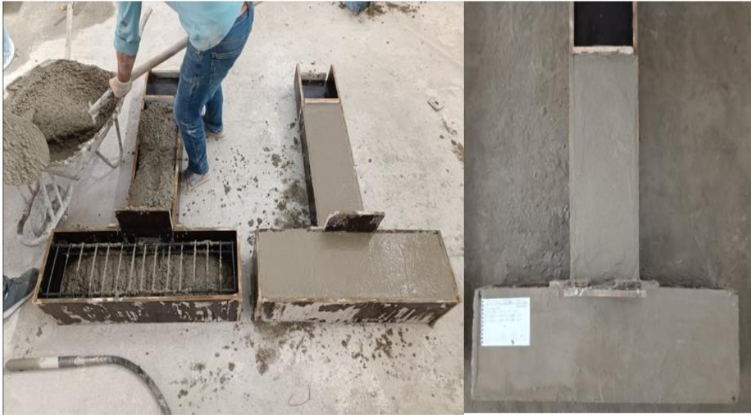
Şekil 3.35. Vibratör ile sıkıştırma işlemi ve mala yardımıyla yüzeyin düzeltilmesi
