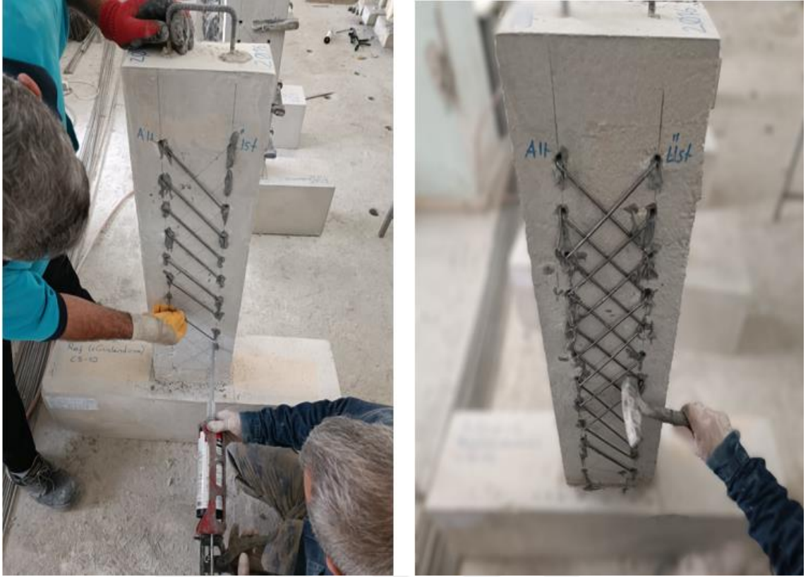
Şekil 3.43. Mekanik dikişlerin deliklere yerleştirilmesi
