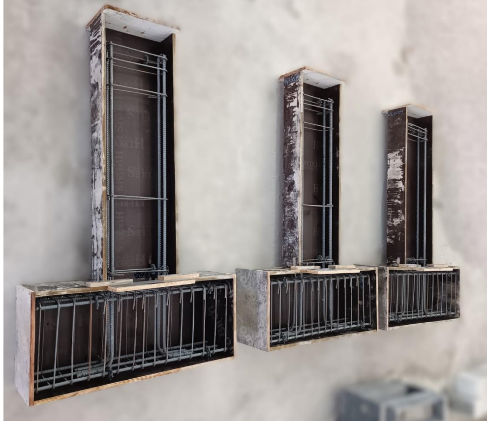
Şekil 3.33. Donatı ve kalıp montajı tamamlanmış numuneler
