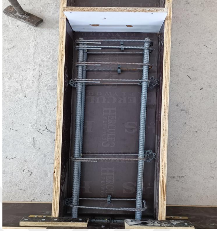
Şekil 3.32. Kirişlerin alt ve yan bölgelerinde kullanılan pas payı aparatları
