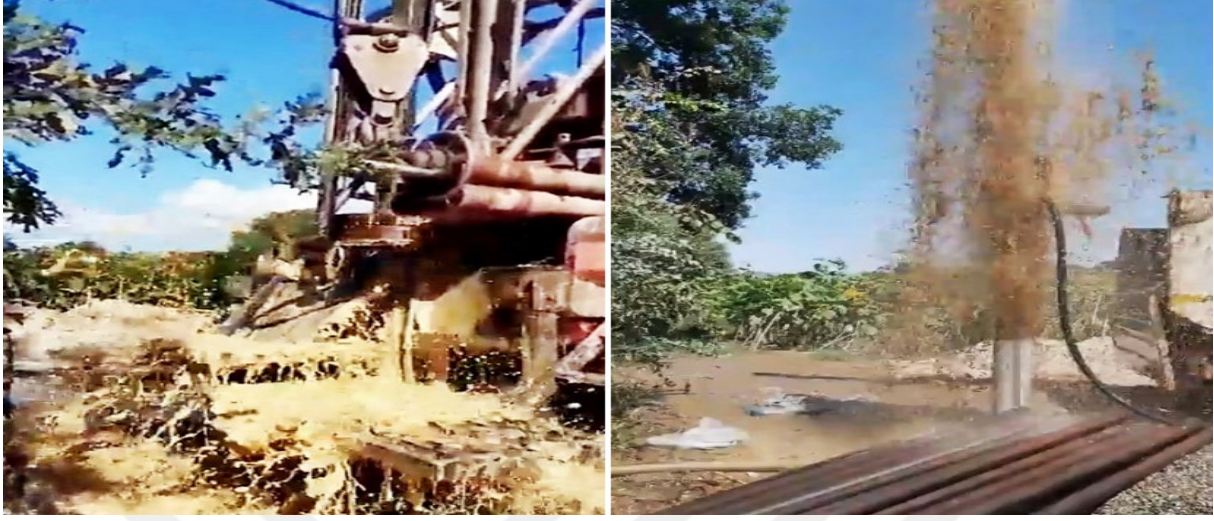
Fotoğraf 2.2 Bölgede Yapılan Yeraltı Suyu Arama Çalışması
