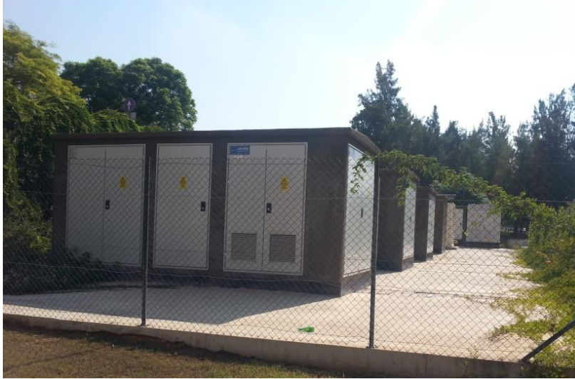
Şekil 3.1. Ölçüm Yapılan A2 Trafo Binası
