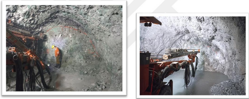
Şekil 3.11. Jumbo ile delme işlemi yapılması.
