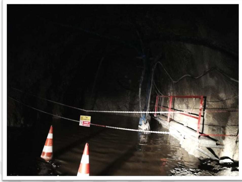
Şekil 3.14. Ocak içerisindeki çöktürme havuzlarından görünüm.
