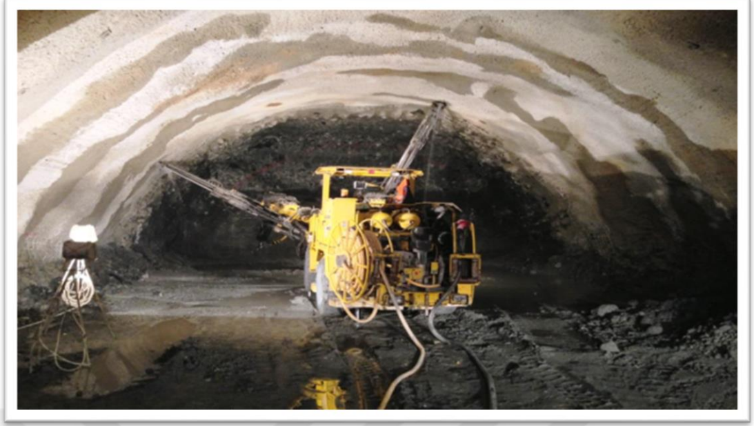
Şekil 3.12. Beton püskürtme uygulaması (SYMMM, 2018).
