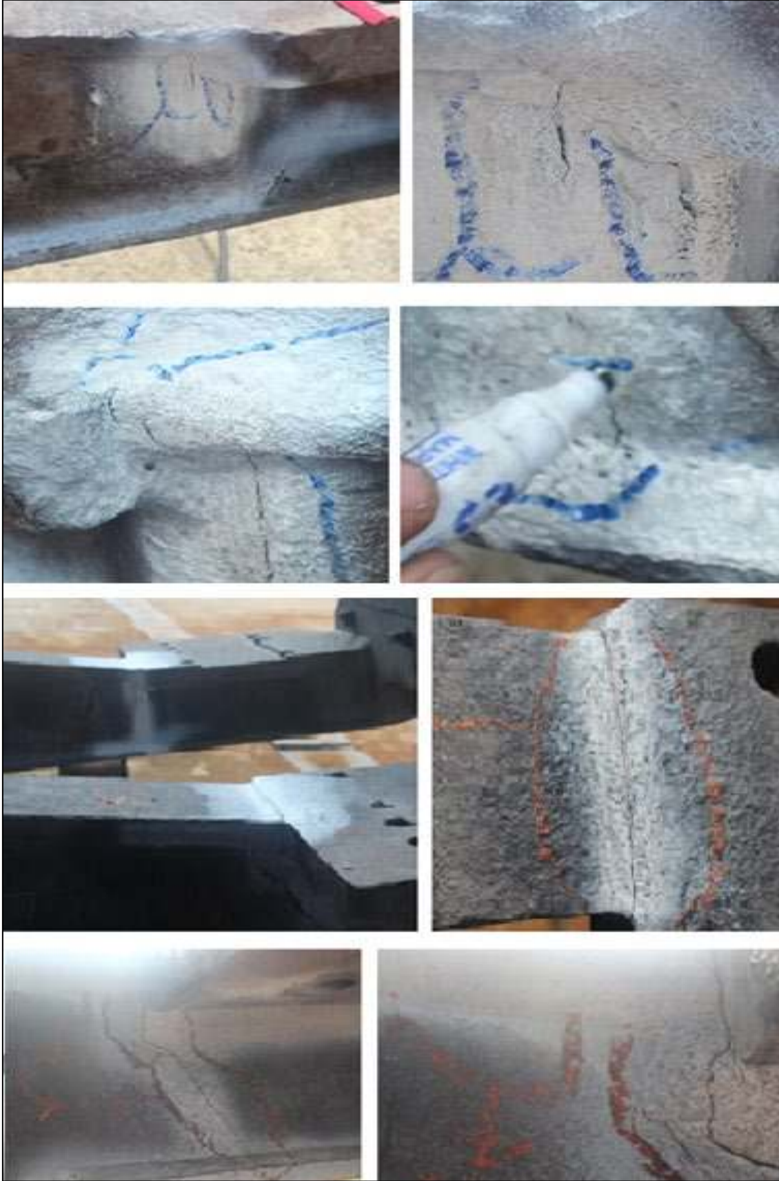
Şekil 95. Alt şasi arka ayaklarında görülen hasarlar
