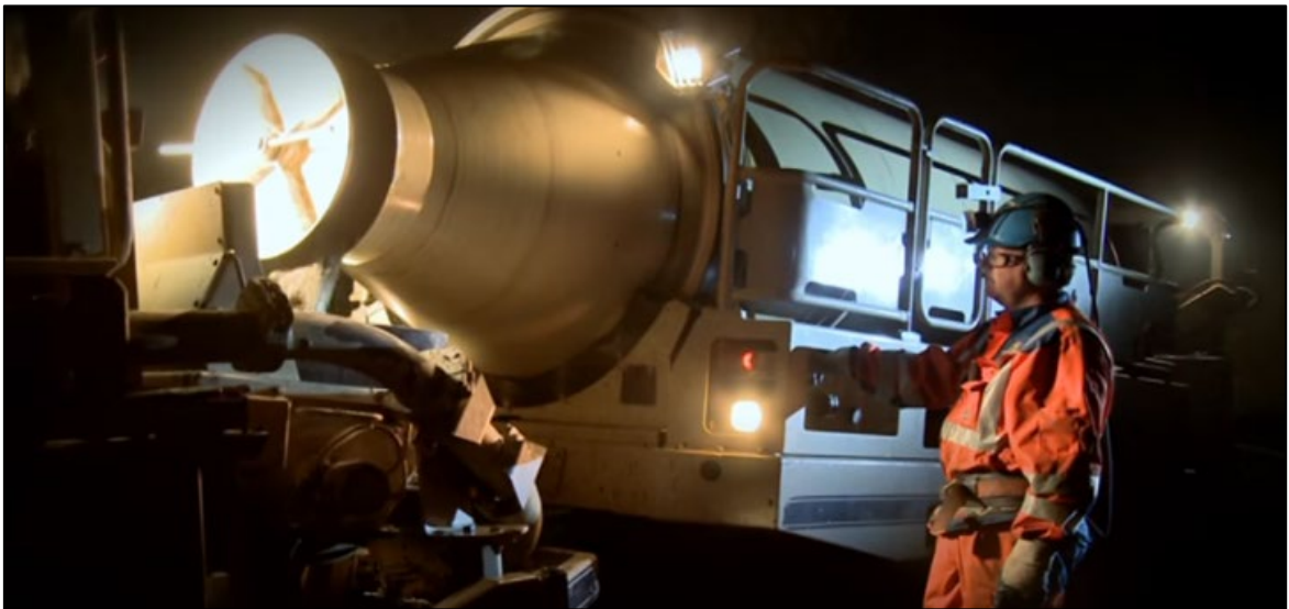
Şekil 29. Betonun, mikser kazanından dışarı transferi [12].
