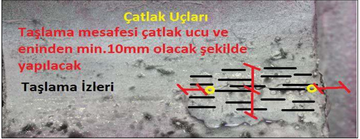
Şekil 56. Aşırı ilerlememiş çatlakların taşlama işlem prosedürü
