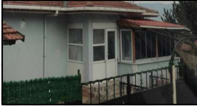
Fotoğraf 4.2. Taşlık Köyü Yeni Yerleşim Yeri Konut Duvar Görünümü
