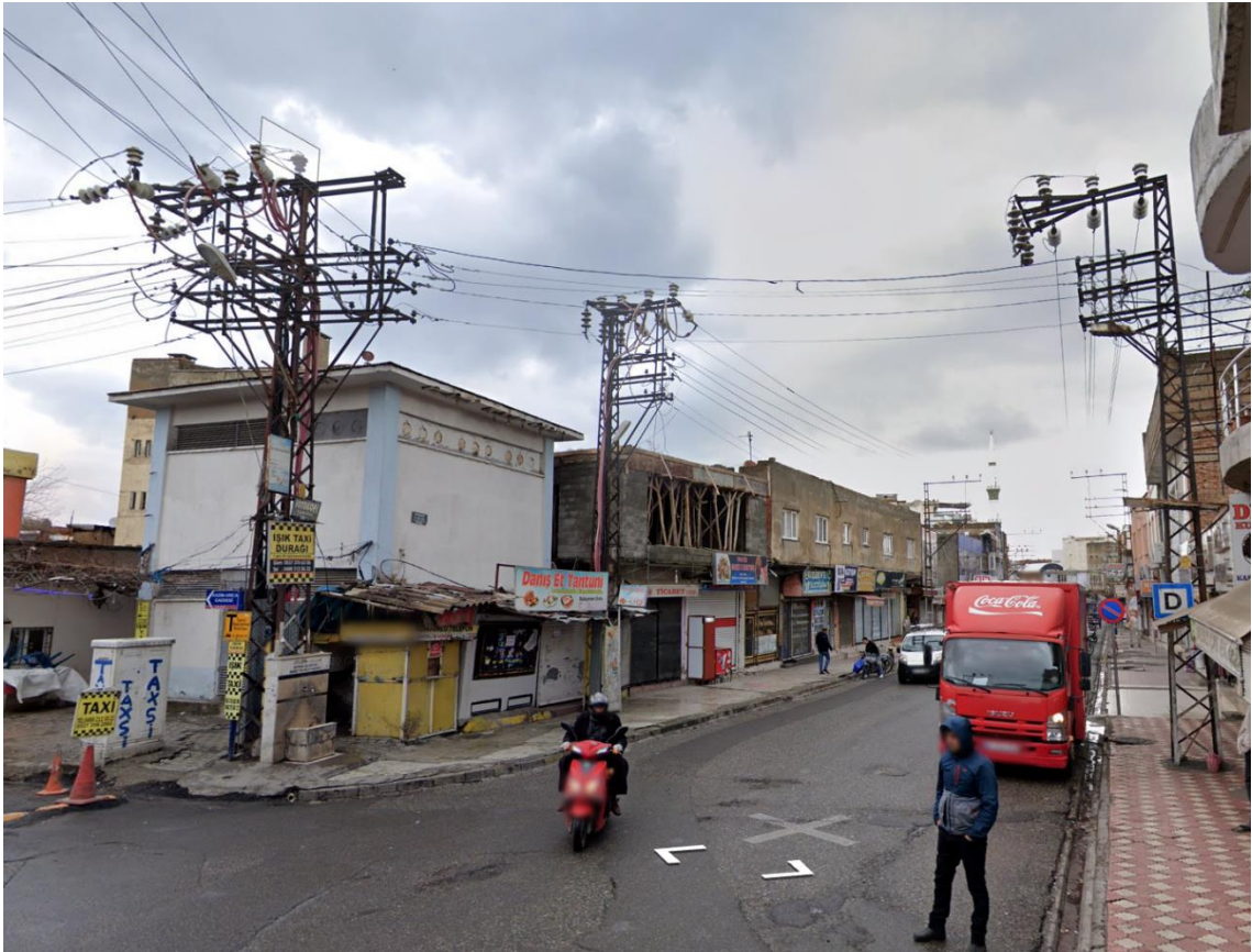
Şekil 4.4. Şehir içi Havai Hatlı Elektrik Dağıtım Şebekesi
