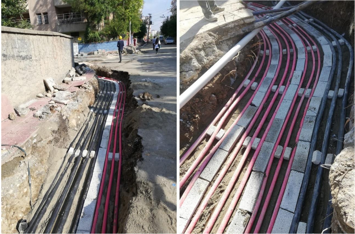
Şekil 4.5. Şehir içi Yeraltı Elektrik Kablo Montaj Uygulamaları
