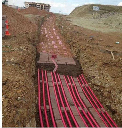
Şekil 2.1 Yeraltı kablolarının döşeme şekli örneği (İnt. Kyn. 2).
