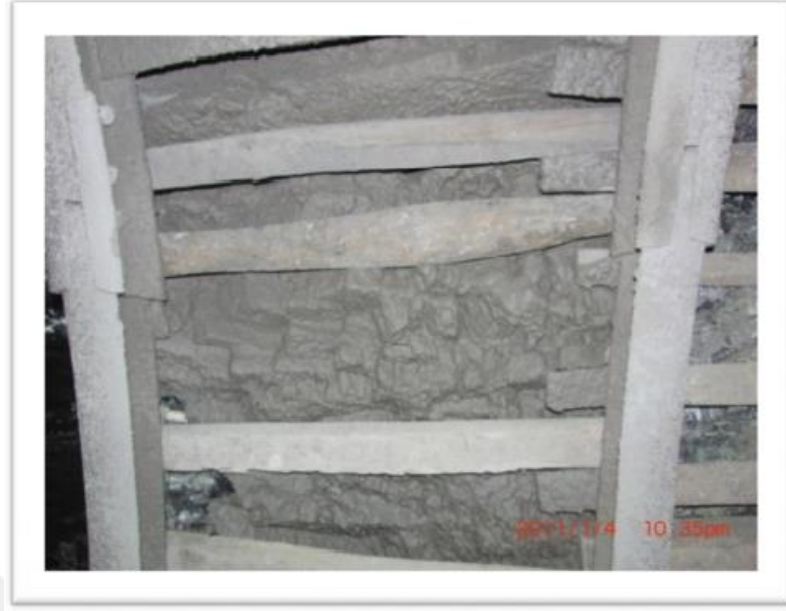
Şekil 5.6 Kaplama malzemesinin tahkimat arkasına yerleştirilmesi (Bayraktar, 2013)
