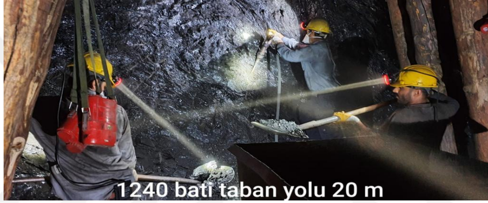
Şekil 2. Erzurum ilinde bir yeraltı kömür madeni işletmesinin görüntüsü (Kömür madeni işletmesinin kurumunun izni ile)
