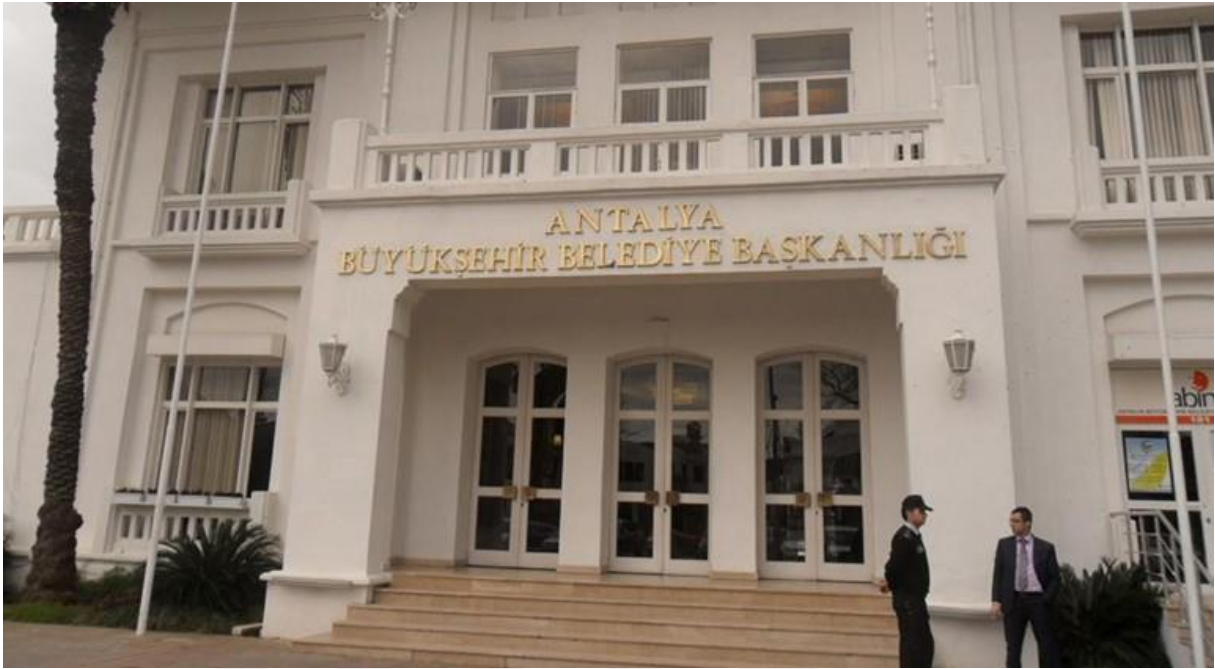
Görsel 2.47 Büyükşehir Belediye Binası
