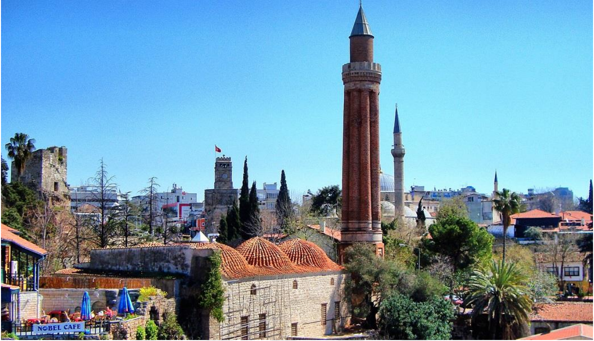
Görsel 2.16 Yivli Minare Camii
