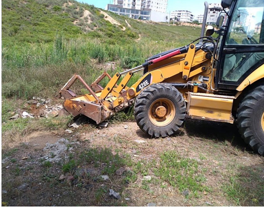
Şekil 4.10. İnşaat ve yıkıntı atıkları toplama çalışması
