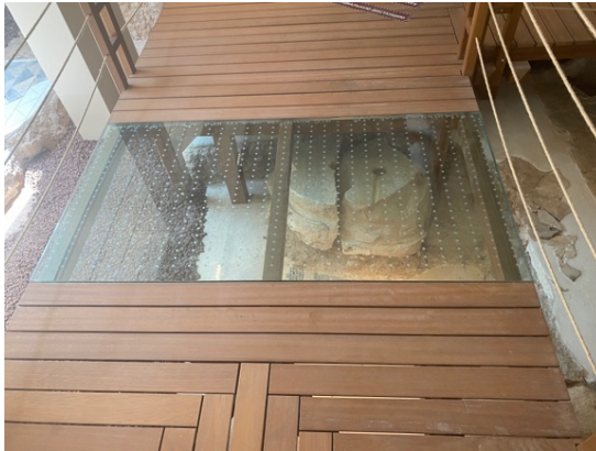
Şekil 4.10. Lamine cam döşeme üzerinde yer alan beyaz noktalı serigrafi baskı (Orijinal 2021)
