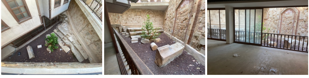
Şekil 3.36. 148 ada 31 parselde bulunan yapının fotoğrafları (Orijinal 2021)
