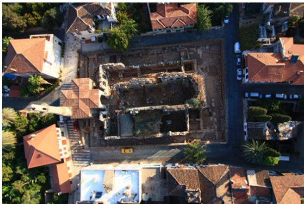
Şekil 3.21. 111 ada 2-3-8-9-10-17 parselde bulunan Şehzade Korkut (Kesik Minare) Cami'nin restorasyon öncesi görünümü (Anonim 15 2021)
