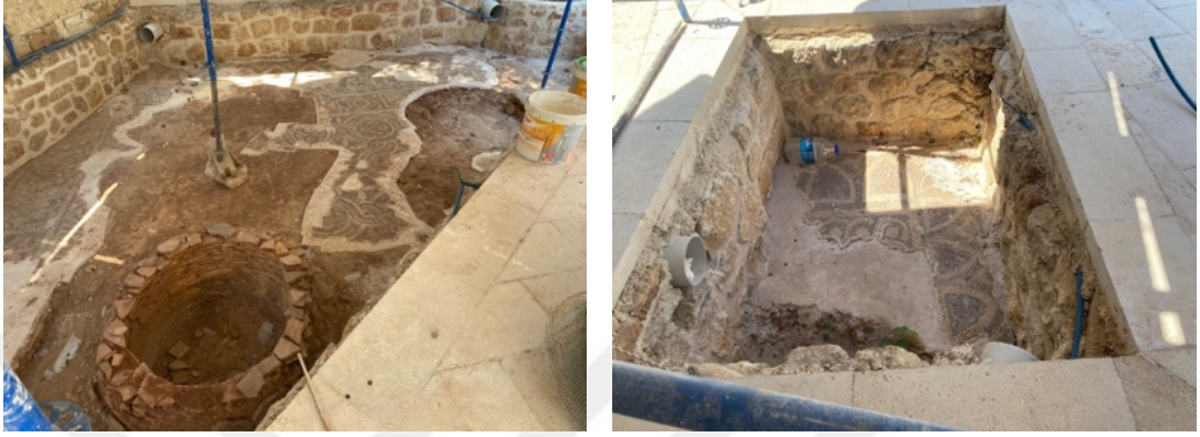
Şekil 3.27. 146 ada 1 parselde kazı sonucu ortaya çıkan mozaik zemin (Orijinal 2021)
