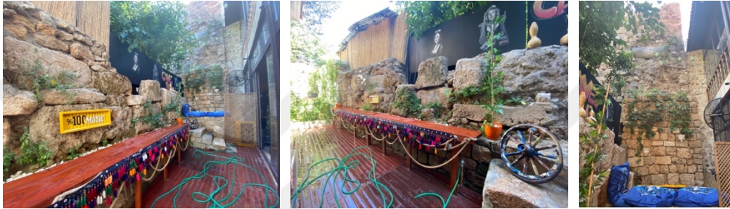
Şekil 4.15. 156 ada 17 parselde yer alan yapı ve sur duvarı kalıntısı (Orijinal 2021)
