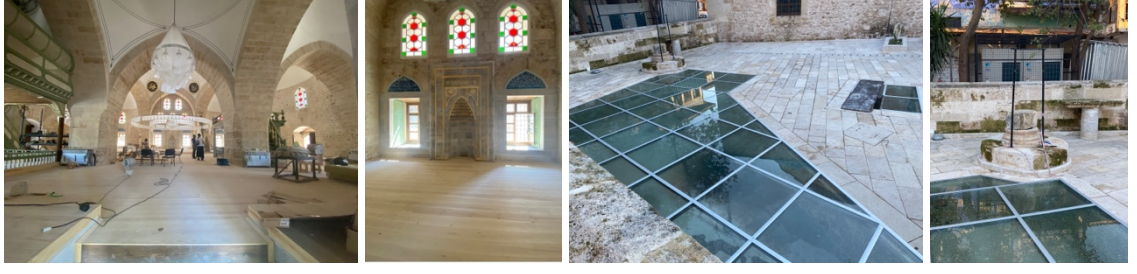
Şekil 3.29. 146 ada 1 parselde bulunan yapının fotoğrafları (Orijinal 2021)
