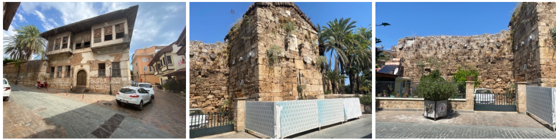
Şekil 4.14. 115 ada 10 parselde yer alan yapı ve sur duvarı kalıntısı (Orijinal 2021)
