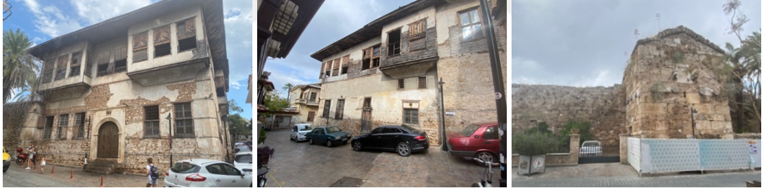
Şekil 3.48. 115 ada 10 parselde bulunan yapının fotoğrafları (Orijinal 2021)
