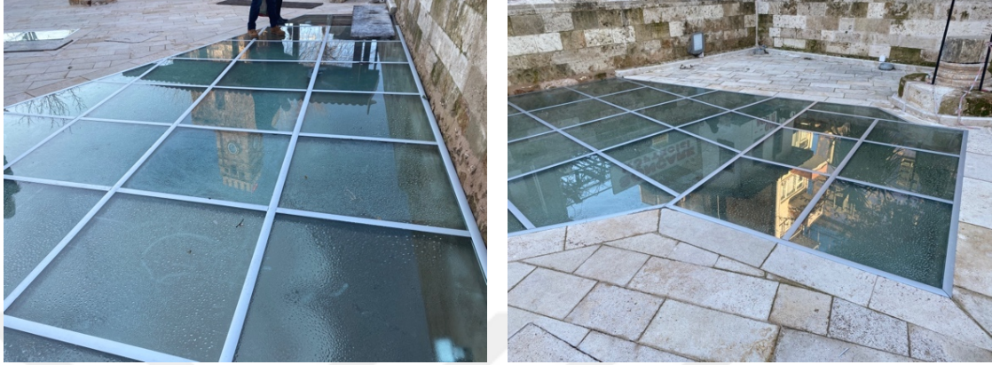
Şekil 4.11. Lamine cam döşemede yoğunlaşma oluşması (Orijinal 2021)
