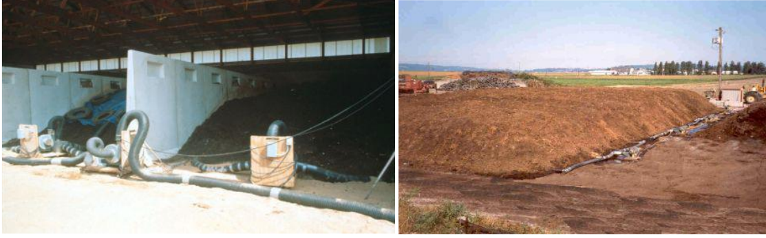
Şekil 26: Havalandırmalı Statik Yığın Yöntemi
