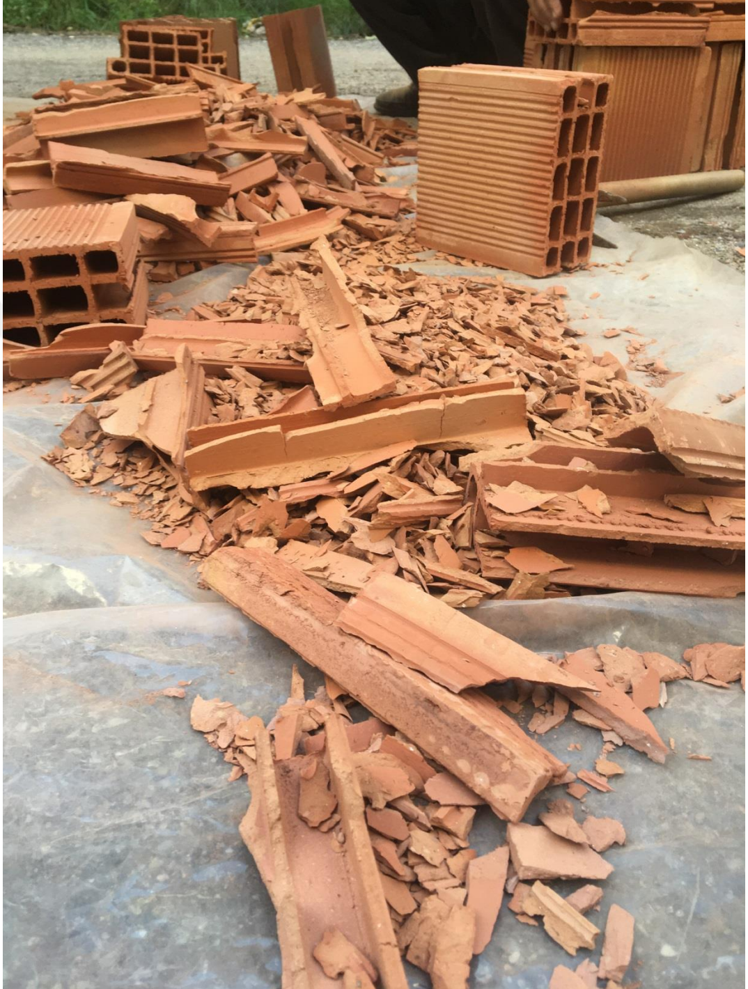
Fotoğraf 54: Tuğlaların silindir formda yüксеlebilmesi için eksiltilen parça görseli.
