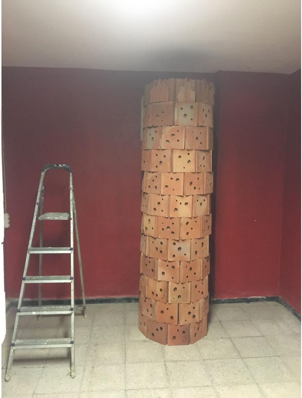
Fotoğraf 64: Tuğlaların silindir formda dizilim aşama görseli.
