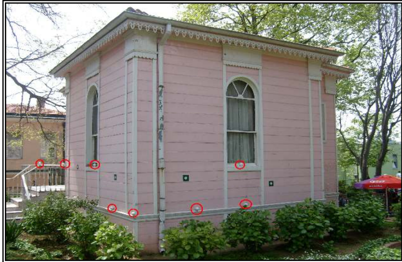
Şekil 8.36 Referans küre ve hedef noktalarının Pembe köşk üzerine yerleştirilmiş görüntüsü
