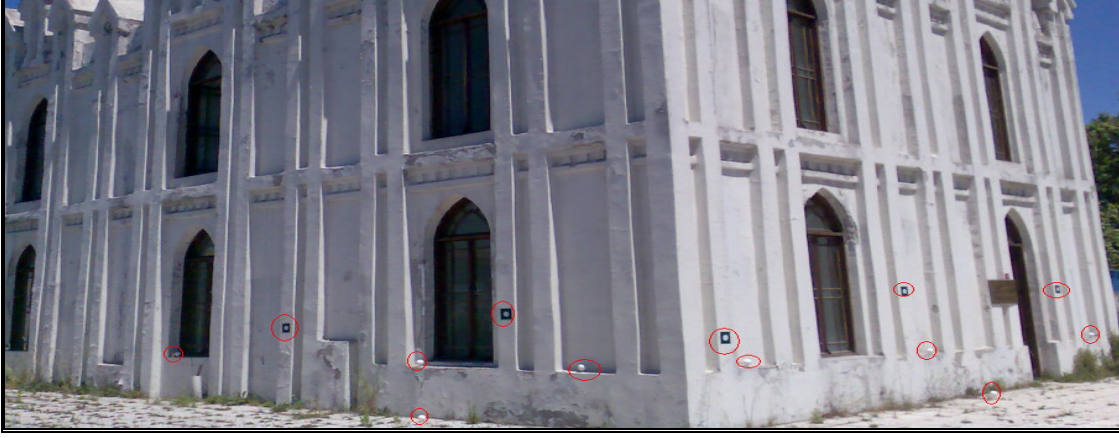
Şekil 8.11 Küre ve hedeflerin bina yüzeyine yerleştirilmiş görünümü
