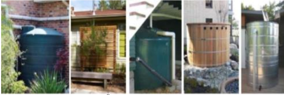
Şekil 1.3.Yağmur Suyu Tankı Örnekleri (Dereli, 2020)
