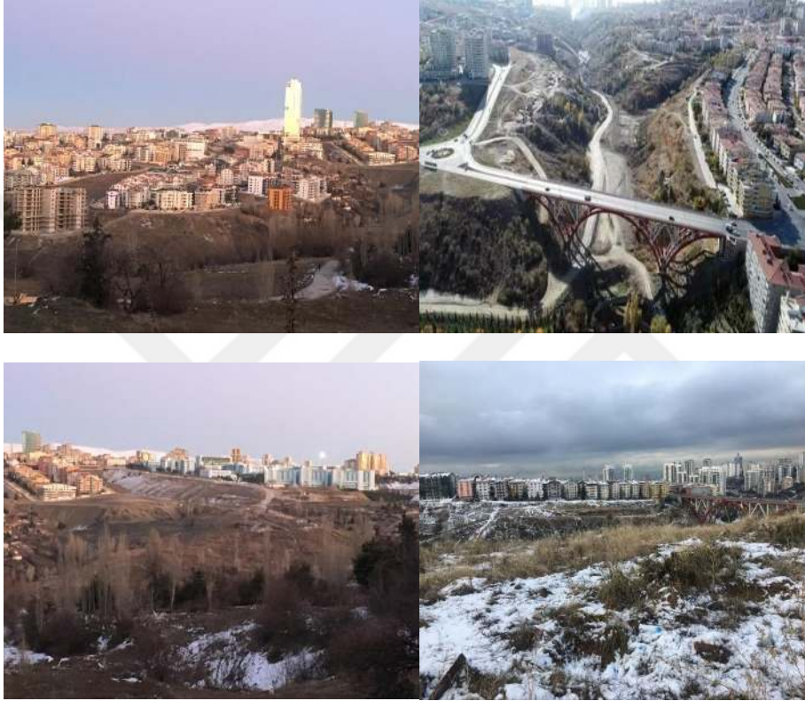
Şekil 3. 13.Dikmen Vadisi IV. ve V. Etap Genel Görünümü (Tiğiz, 2019)
